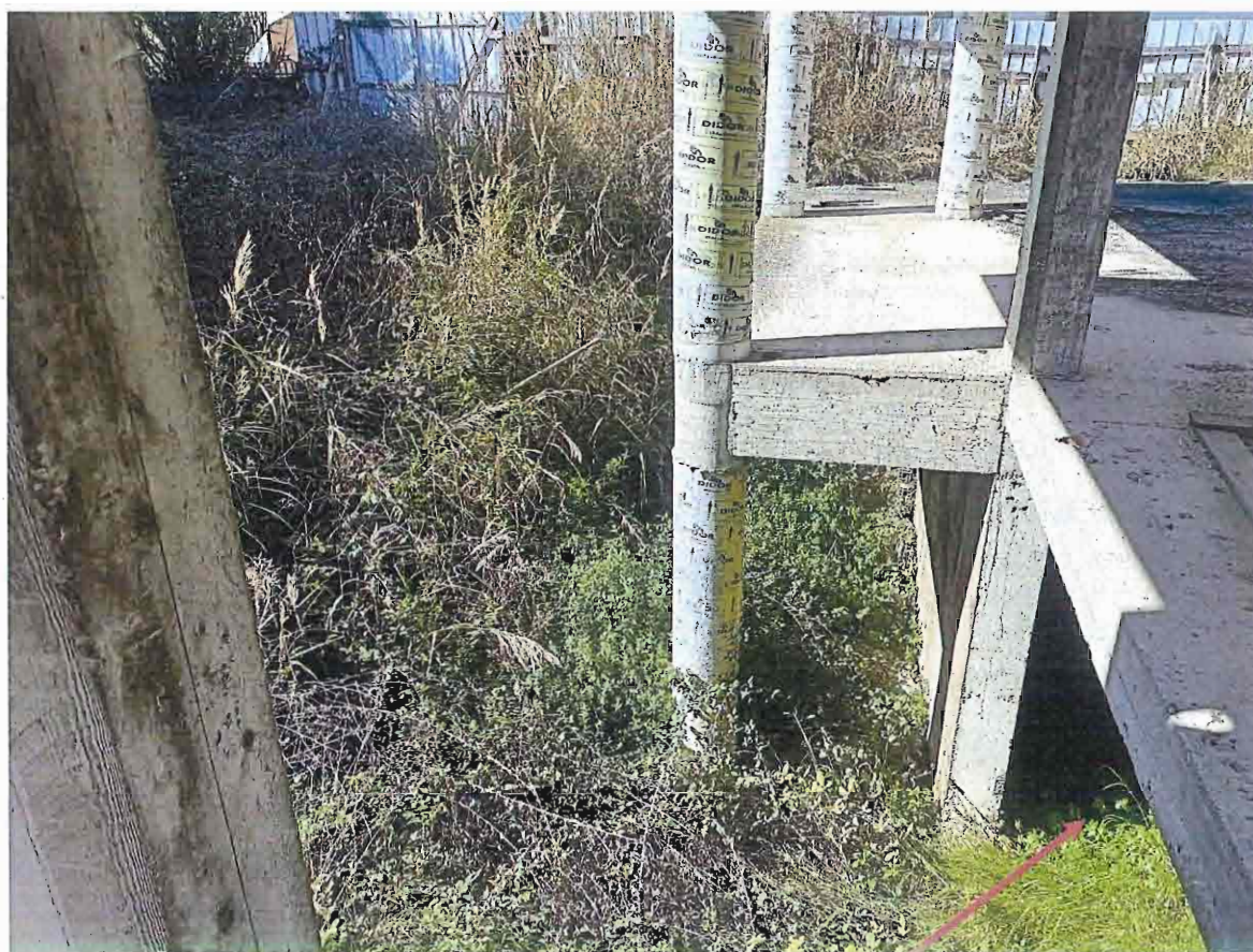
Ingresso piano interrato
