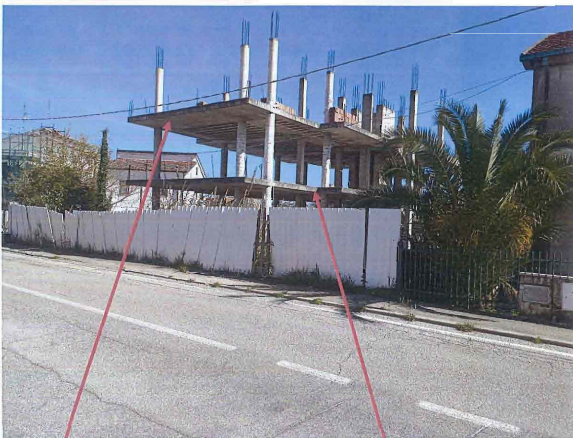
Solaio piano secondo
