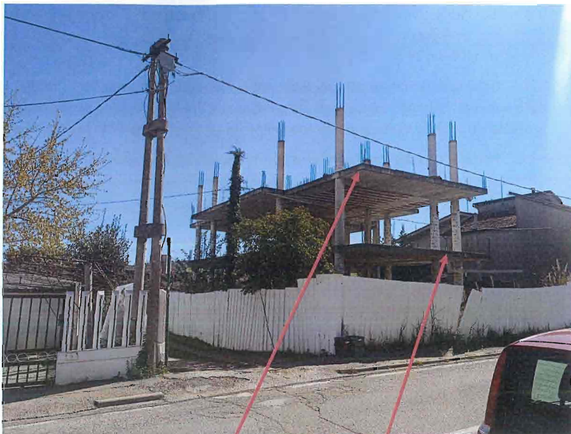
Solaio piano secondo
